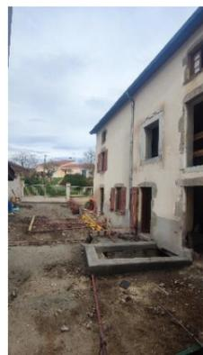
Depuis le mois de janvier le chantier du bâtiment du tiers-lieu a bien avancé. Les planchers du premier étage ont été déposés et remplacés par une dalle en béton, posée par l'entreprise Sanchez. Le plancher bois (pin) du troisième étage est à présent installé, fruit du travail de l'entreprise Taillandier.
